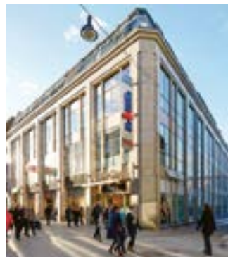
12 Rostock, Kröpeliner Straße 57
