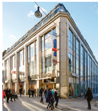
12 Rostock, Kröpeliner Straße 57
