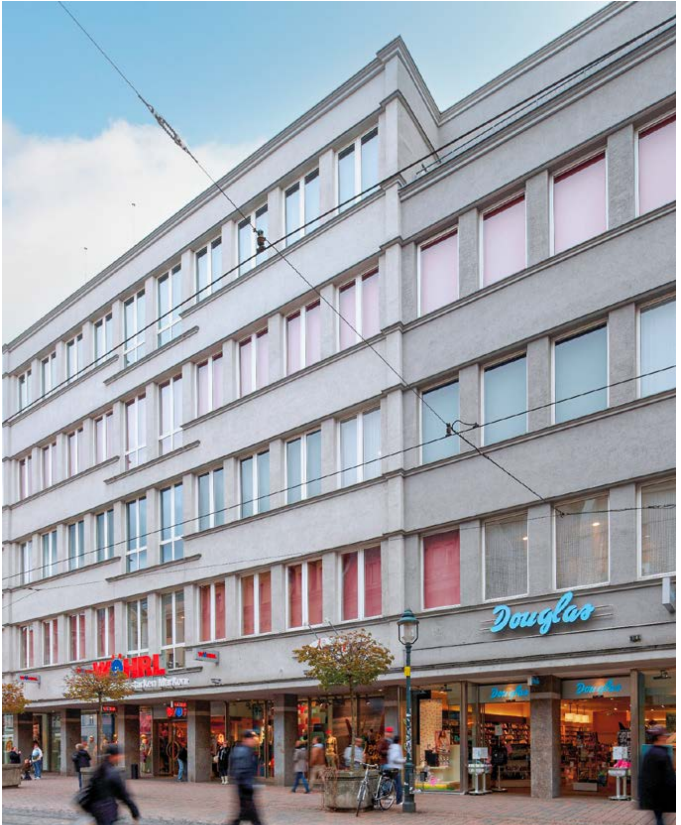
Augsburg, Bürgermeister-Fischer-Straße 5, Moritzplatz 7: Bestandsimmobilie
