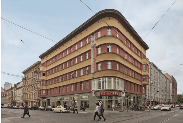
Bestandsimmobilie in Berlin, Neue Schönhauser Straße 10. Die Einzelhändler in Berlin konnten 164 Neuvermietungen abschließen. Damit ist die Stadt Spitzenreiter.
