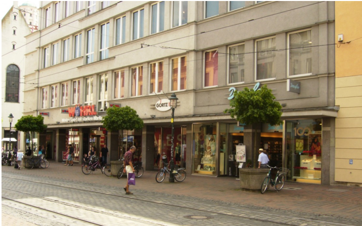
Foto: Einzelhandelslagen, wie unser Objekt Bürgermeister-Fischer-Straße 5/Moritzplatz 7 in Augsburg (im Ankauf) teilen die Probleme der Einkaufszentren nicht.
