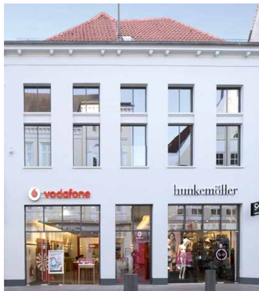
Nach Kernsanierung: Flensburg, Holm 70
